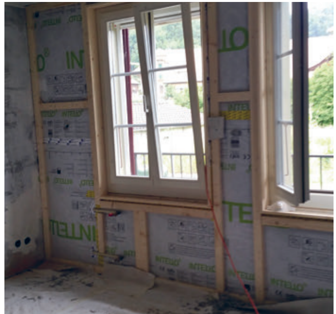
3 pav. Įpučiama celiuliozės apšiltinimo medžiaga vidinėje sienos pusėje („Auraplan“ nuotrauka)
