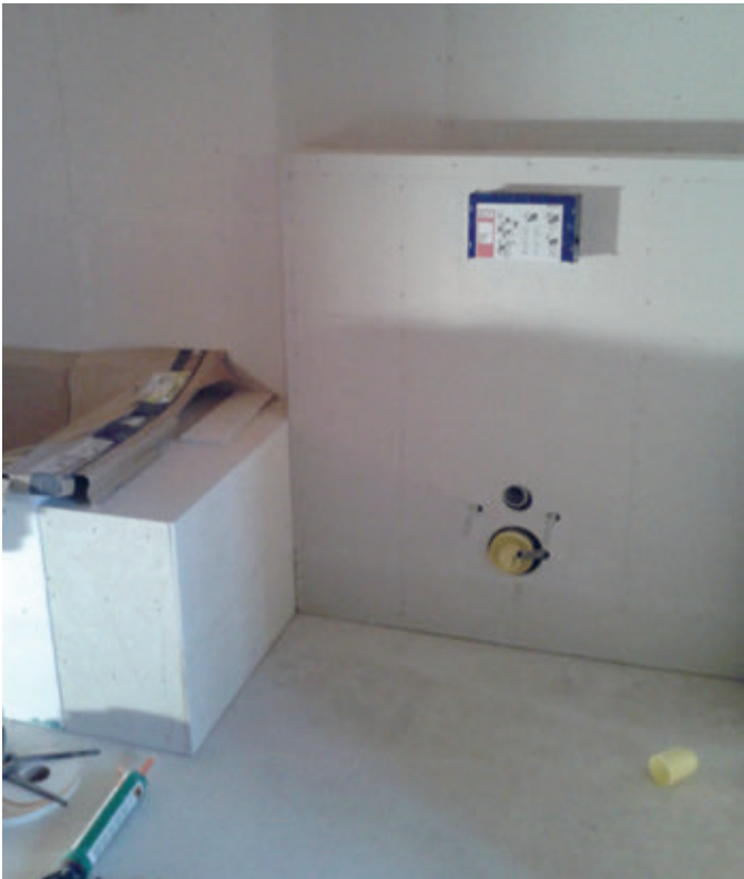
7 pav. „Fermacell“ plokštės vonios kambaryje („Auraplan“ nuotrauka)
